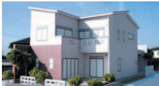
Structured by **SE構法** 「重量木骨の家」の構造を形成しているのが国土交通大臣認定の「SE構法」です。主要構造部材には品質の安定した構造用集成材を使用し、それらを接合する部分にはオリジナルSE金物で頑丈に接合しています。これにより、壁のみで構造を支える一般的な木造や2×4工法では不可能な大空間や大開口が可能になり、「ワンルーム=ワンフロアの大空間」「開放感あふれる吹き抜け」「たくさん光を取り入れる大開口窓」「究極の開放空間である屋上ルーバルコニー」など、自由性の高い空間を実現することができます。
