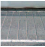
さすらいの……」と、ちょうど良いテンポの「琵琶湖周航の歌」が聞こえてくる。メロディーが響く仕組みは、溝と溝の間隔が狭いと高音、広いと低音になる原理を応用したもので、雨天時には排水効果が高まり、滑り止めにもなる。滋賀県道路公社によると、全国では北海道や和歌山、愛知など10カ所に設置されているが、橋に施されたのは琵琶湖大橋が初めて。長さは約610mで、最長区間になる。「交通安全とともに、観光資源として琵琶湖大橋の利用の促進に
